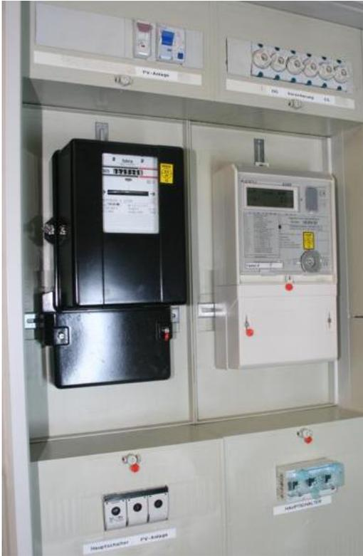
**Zählerschrank** mit Einspeise und Bezugszähler, AC\*-Sicherungen, bzw. Leitungsschutzschalter.
