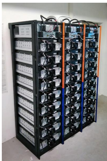
Abbildung 4: Batteriesystem bzw. Batterie; Zusammenstellung von Batteriepacks oder Modulen, die eine funktionsfähige Einheit darstellen, in einem Gehäuse.
