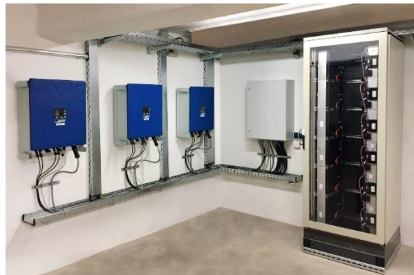
Abbildung 3: Lithium-Ionen Großspeicher in einem Wohngebiet
