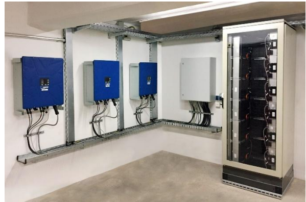
Abbildung 6: Lithium-Ionen-Großspeicher innerhalb eines Gebäudes
